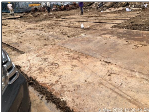
ภาพที่ 17 แผ่นเหล็กปูภายในพื้นที่โครงการ
