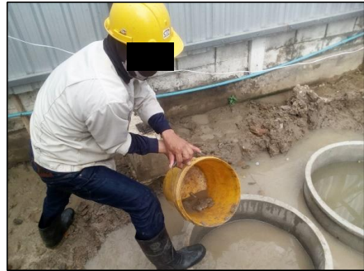
ภาพที่ 28 บ่อดักดินและการขุดลอกตะกอนดิน
